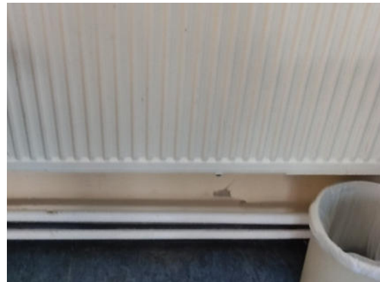
Sockelschaden Speiseraum
