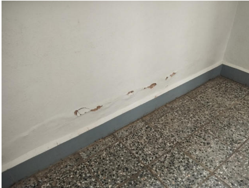
Sockelschaden Flur
