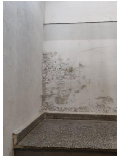
Feuchteschaden Kellerniedergang
